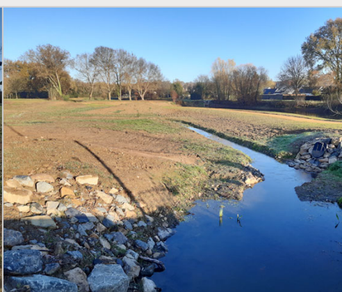
Suppression du seuil de l'ancien étang communal et restauration du ruisseau
