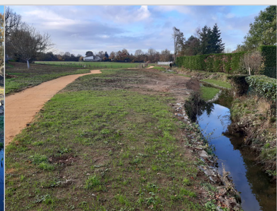
Retalutage et resserrement du lit à l'aval avec suppression d'un muret
