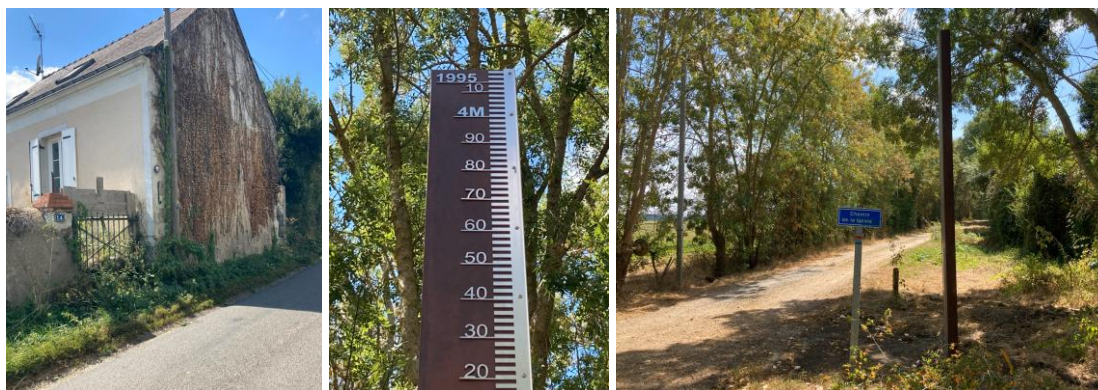
Repère et totem de crues posés sur Soulaire-et-Bourg
