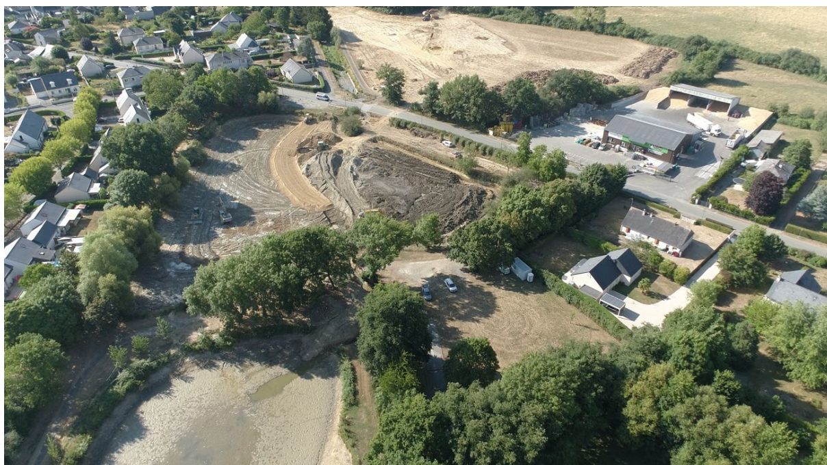
Chantier du Piron (© SMBVAR)
