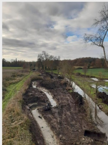
Nouveau lit méandriforme en cours de création à côté de l'ancien lit rectiligne
