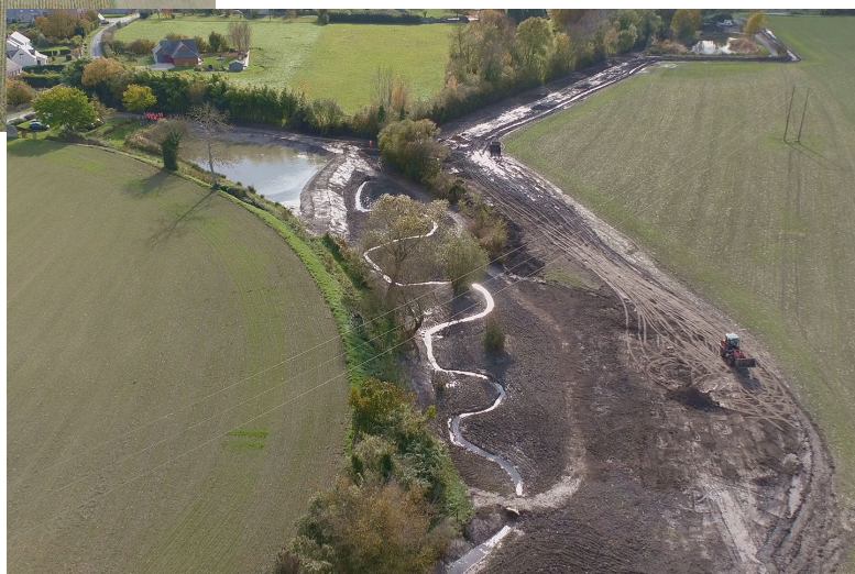
Ruisseau de Marcé avant et après reméandrage au sein de l'emprise du plan d'eau communal (© Culture Biome)
