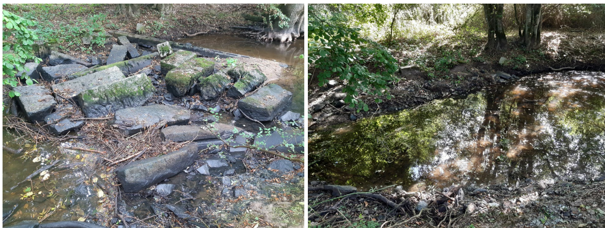
Suppression d'un obstacle sur la Romme (© SMBVAR)
