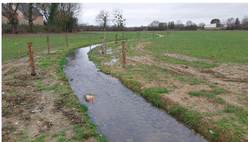
Nouveau tracé méandriforme du ruisseau du Piron en janvier 2026 (© SMBVAR)
