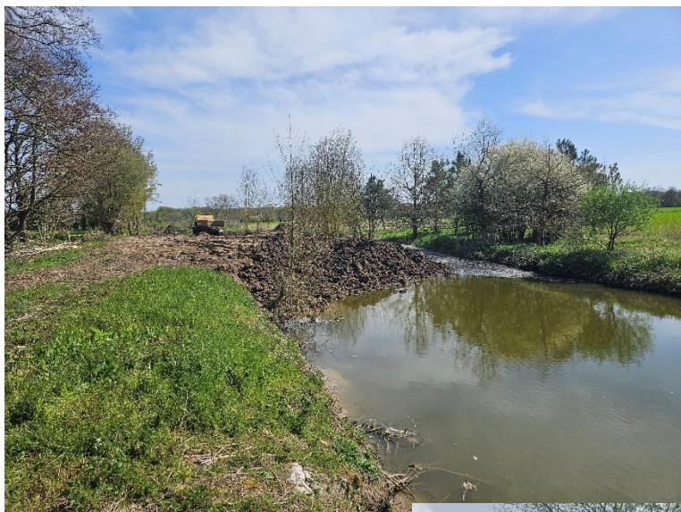
Ci-contre : plan d'eau en cours de remblaiement
