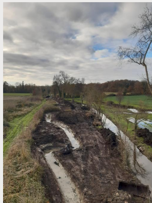
Nouveau lit méandrique en cours de création à côté de l'ancien lit rectiligne
