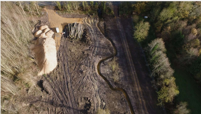
Vue aérienne du secteur 1 en cours de reméandrage
