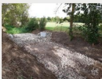
Pose d'un ouvrage de répartition des débits
