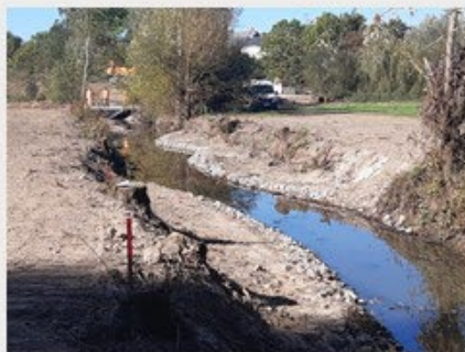
Création de banquettes dans le lit mineur
