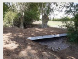
Pose de passerelle
