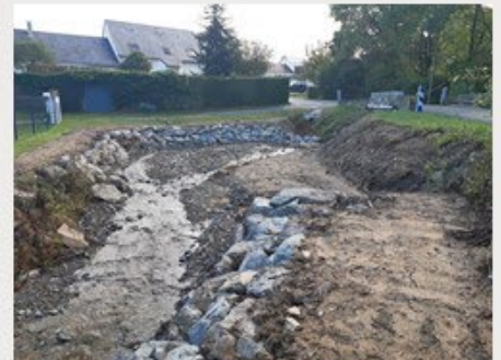
Comblement de la chute en aval de la RD et renforcement des berges
