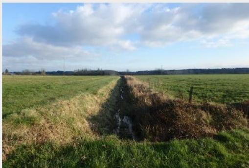
Morphologie du cours d'eau avant travaux
