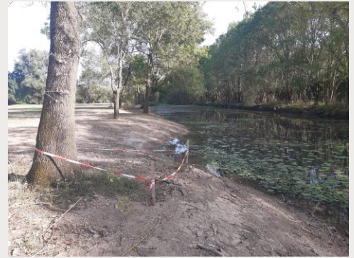
Retalutage des berges du plan d'eau avec mise en défens d'une espèce protégée
