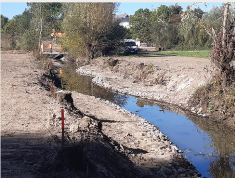
Création de banquettes dans le lit mineur
