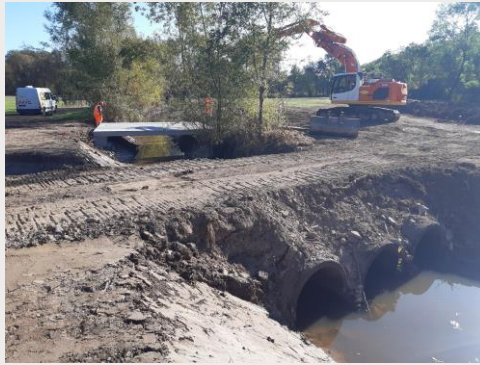
Création d'une passerelle (arrière plan) en remplacement d'un ouvrage busé à supprimer (premier plan)
