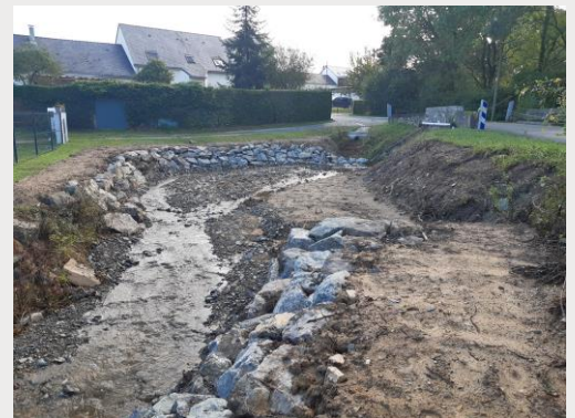
Comblement de la chute en aval de la RD et renforcement des berges
