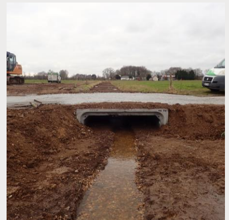
Installation du pont cadre en remplacement d'une buse
