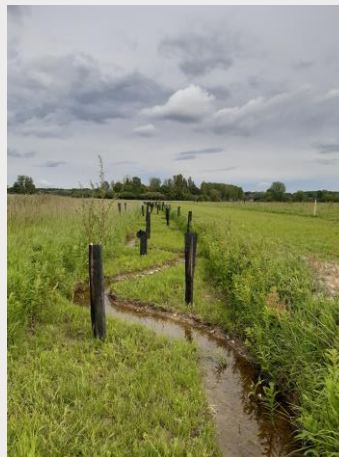
Nouveau tracé méandrique quelques semaines après la fin des travaux
