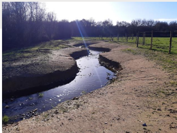
Reméandrage à l'aval
