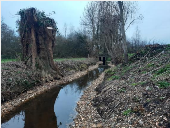
Recharge granulométrique en amont du pont D287
