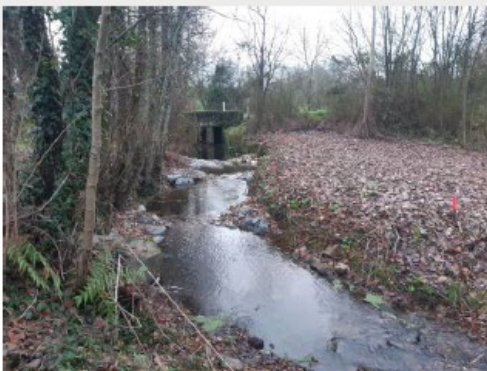
Amélioration du franchissement à l'aval du pont
