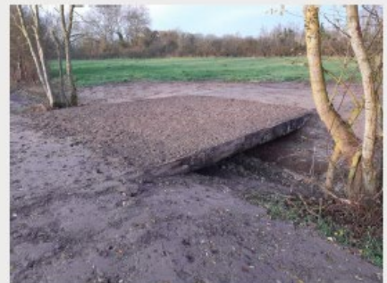
Pose de passerelles
