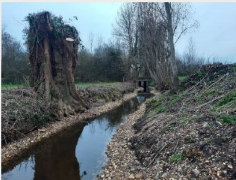
Recharge granulométrique en amont du pont D287
