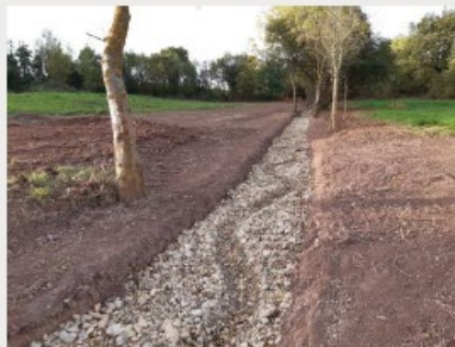
Lit réhaussé et rechargé
