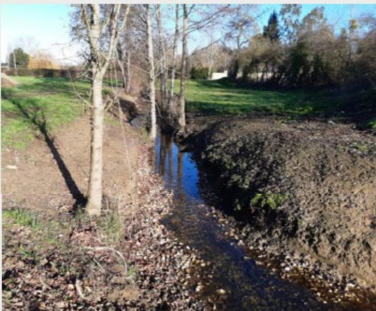
Recharge granulométrique à l'amont
