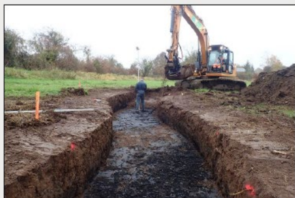
Ci-dessus : terrassement du nouveau lit et mise en place de la granulométrie
