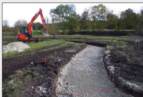
Ci-dessus : terrassement du nouveau lit et mise en place de la granulométrie
