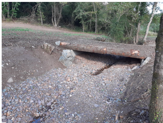
Remplacement d'une buse par une passerelle
