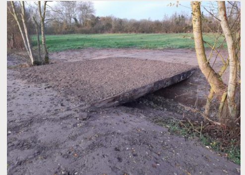
Pose de passerelles
