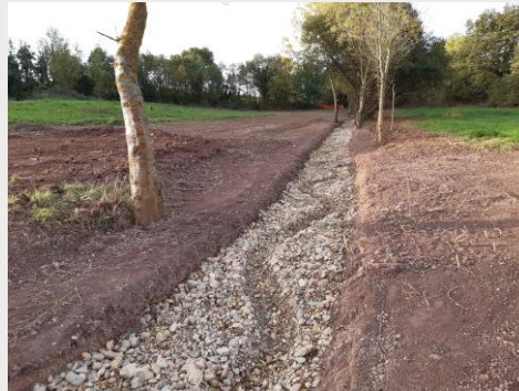
Lit réhaussé et rechargé
