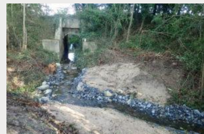
Aménagement de la chute en aval de la voie SNCF
