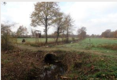
Passage busé avant remplacement par une passerelle
