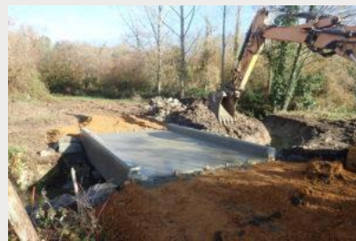
Installation de la passerelle
