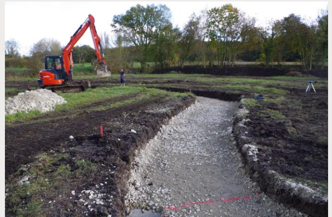
Ci-dessus : terrassement du nouveau lit et mise en place de la granulométrie
