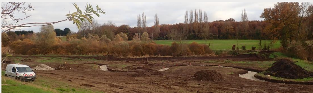
Ci-dessus : terrassement du nouveau lit et mise en place de la granulométrie
