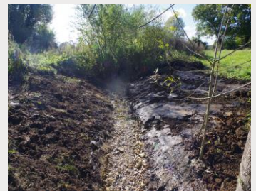
Rehaussement du lit du cours d'eau
