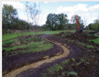
Reméandrage et comblement de l'ancien lit
