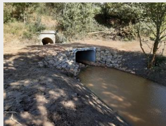
Remplacement par un dalot
