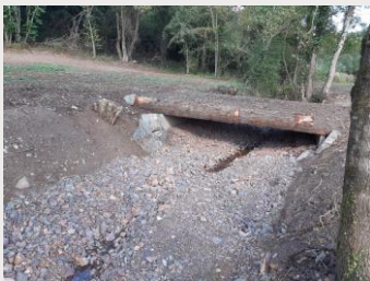
Remplacement par une passerelle
