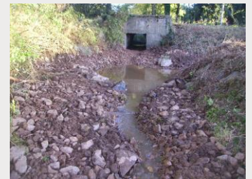
Apport de cailloux en aval du pont
