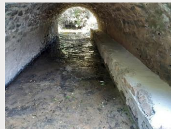
Réalisation d'un passage à faune
