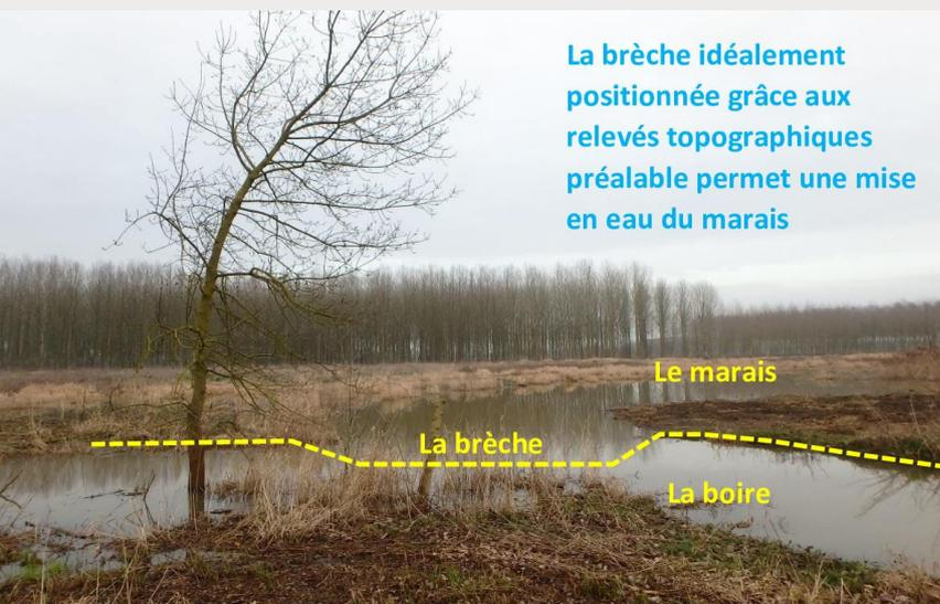
La brèche idéalement positionnée grâce aux relevés topographiques préalable permet une mise en eau du marais
