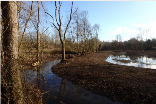
Juste après travaux : boire reconnectée et étang transformé en frayère
